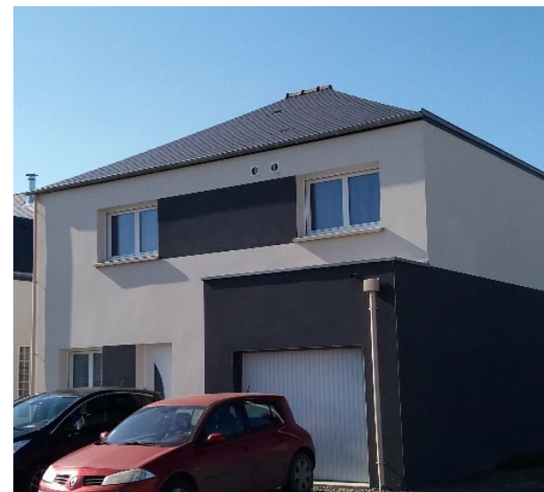
Exemples de toiture, bandeau de façade et de traitement de descente d'eaux pluviales trop contrasté sur façade proscrits
