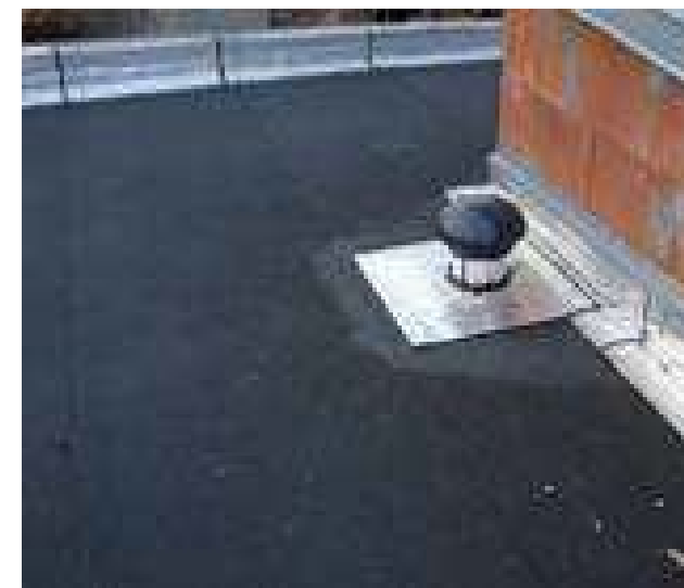
Traitement en simple étanchéité non autorisé pour éviter la gêne visuelle des toits terrasses des volumes en RDC pour les constructions voisines.
