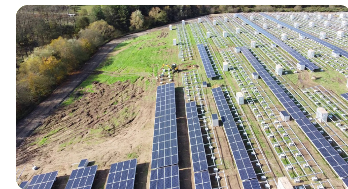
Les 12 000 panneaux solaires en cours d'installation sur l'ancien site d'enfouissement des ordures ménagères.
